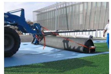
Nachdem die Schaumstoff-Bahnen miteinander verklebt wurden, wird der Kunstrasen ausgerollt.
