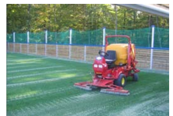
Zum Schluss wird die Gummi-Sand-Mischung über den Kunstrasen verteilt, die für die Festigkeit und Stabilität sorgt.
