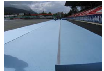
Alveo Sports Layer wird auf dem Fundament des Fußballplatzes verlegt.
